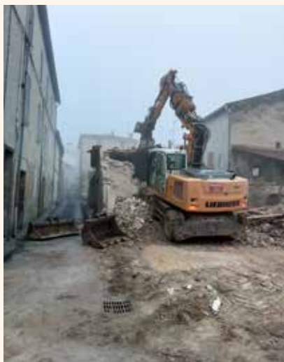
Démolition rue des Religieuses
