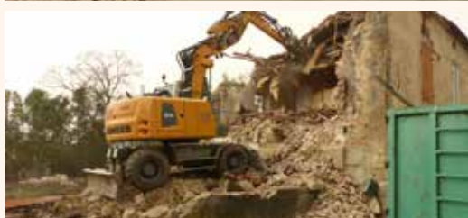
Démolition rue Chanteloube
