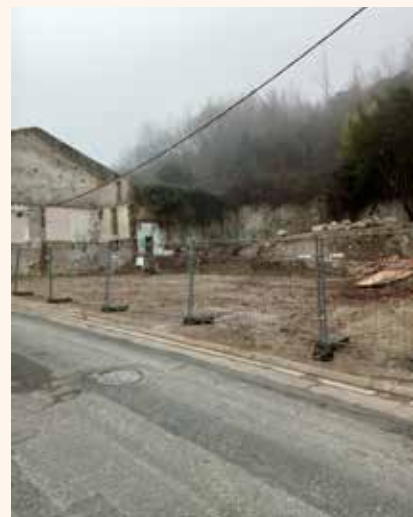
Démolition rue Pasteur
